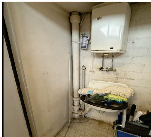
Bild 46: Fallrohr Asbestzement
