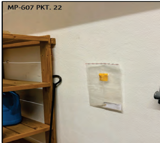
Bild 25: MP607-Pkt. 22, EG/OG/KG, Wandputz innen -- Mischproben
