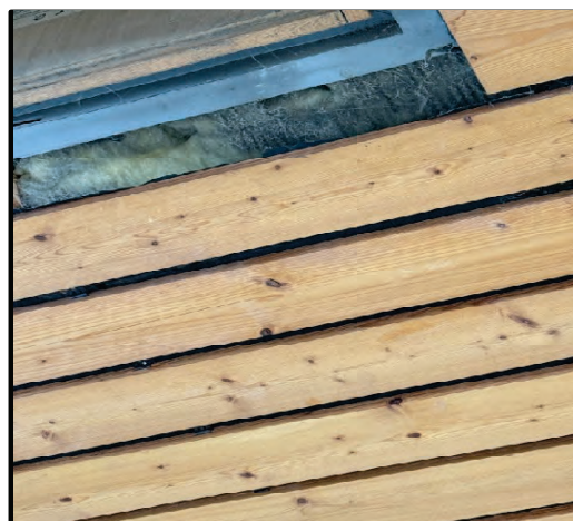
Bild 48: KMF-Dämmung Innendecke
