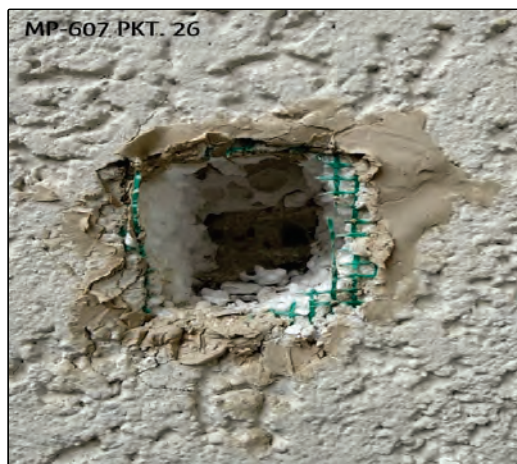
Bild 29: MP607-Pkt. 26, Hauptgebäude außen, Putz mit Gewebe
