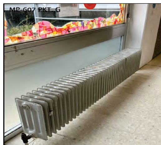
Bild 54: Punkt G Rippenheizkörper
