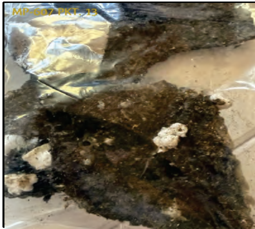
Bild 13: MP607-Pkt. 13, EG Flachdach Anbau, Bitumenbahn
