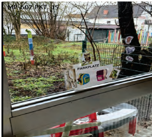
Bild 15: MP607-Pkt. 15, EG Eingangsbereich, Fensterkitt
