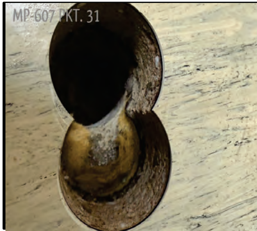
Bild 37: MP607-Pkt. 31, EG/OG, Dämmmaterial unter Estrich
