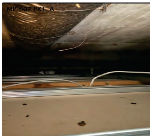
Bild 47: Punkt A Rohrleitungsisolierung
