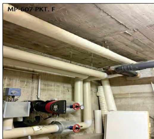
Bild 53: Punkt F Rohrinsolierung
