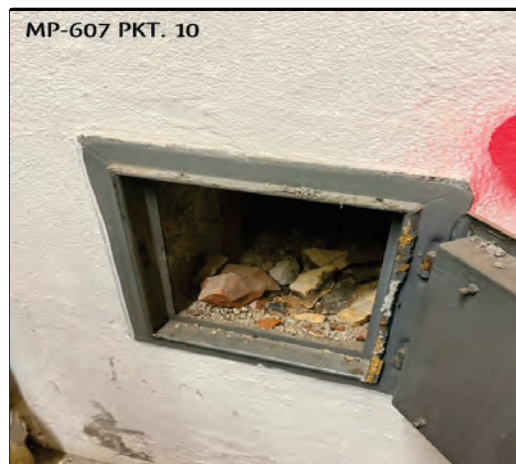
Bild 10: MP607-Pkt. 10, KG Heizung, Schamottstein Kamin
