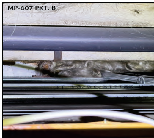
Bild 49: Punkt B Engelshaardämmung
