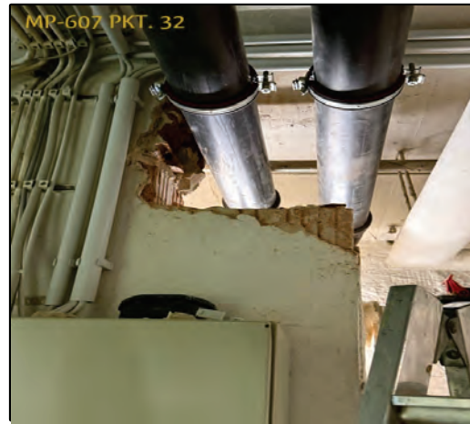
Bild 38: MP607-Pkt. 32, KG Materialraum, Ziegelstein, Mörtel und Putz
