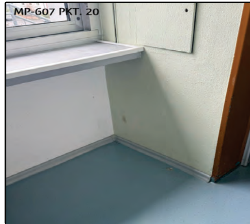
Bild 20: MP607-Pkt. 20, OG Mehrzweckraum, PVC-Belag
